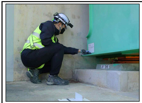
사진번호 56 도보로 하부(거더) 외관망도 - 외관조사현황
