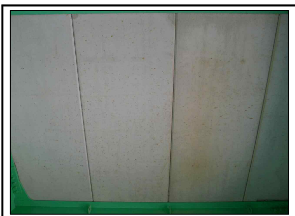
사진번호 23 바닥판 S1 상태양호 외관망도 -
