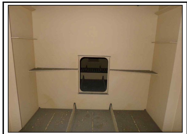
사진번호 30 거더내부 S1 G3 외관망도 - 다이아프레임 상태양호
