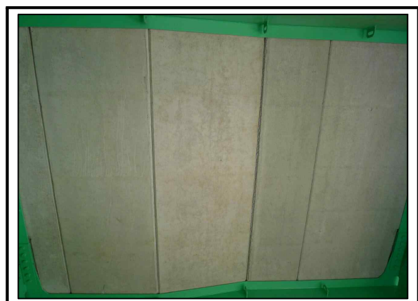
사진번호 24 바닥판 S4 상태양호 외관망도 -
