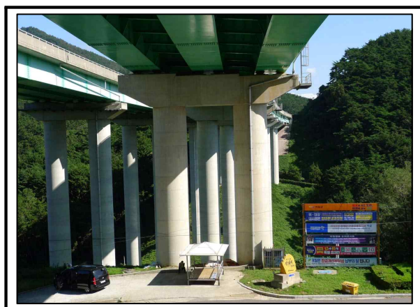
사진번호 46 교각 P1 기초 매립 외관망도 -
