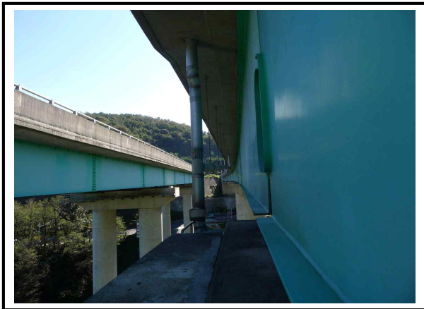
사진번호 7 배수시설 전경 외관망도 -
