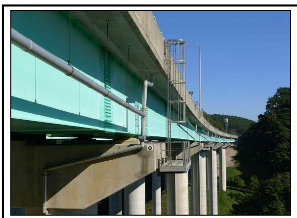
사진번호 47 교각 P1 출입시설(수직형) 설치현황 외관망도 -
