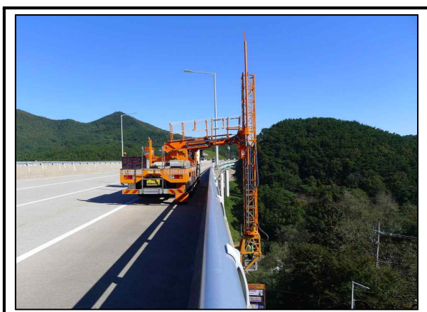
사진번호 59 교량점검차량을 이용한 외관망도 - 외관조사현황
