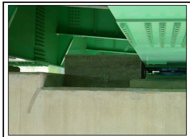
사진번호 36 교량받침 P1 콘크리트 외관망도 - 전단기 설치현황
