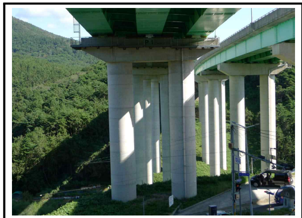
사진번호 12 교각 전경 외관망도 -
